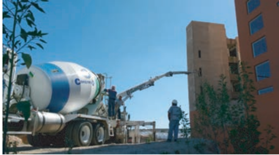
Colocación de firme de concreto
