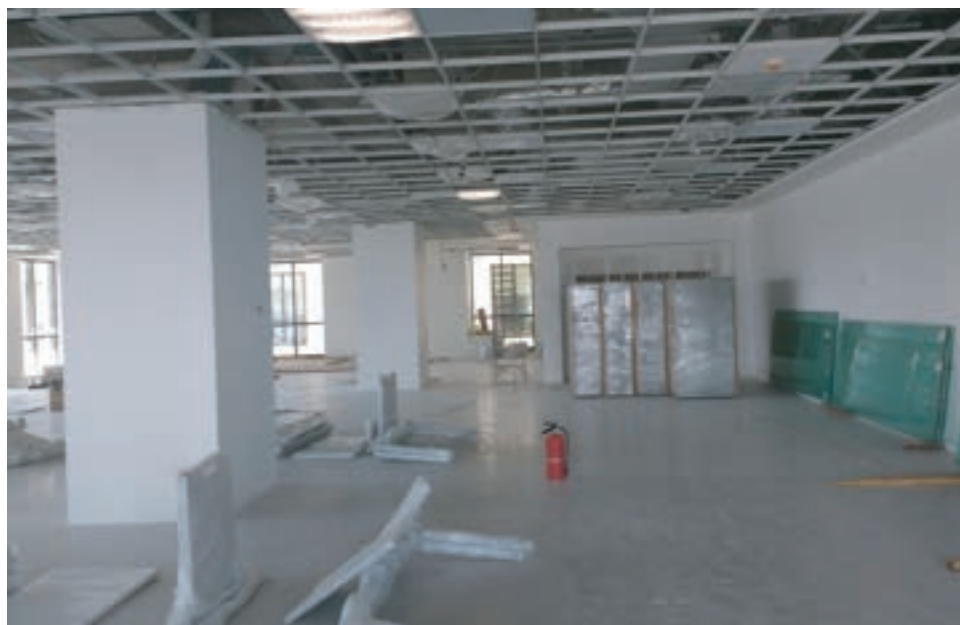
Instalación de plafones
